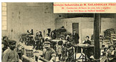
© de la fotografia: Arxiu Municipal de Sant Martí de Provençals
